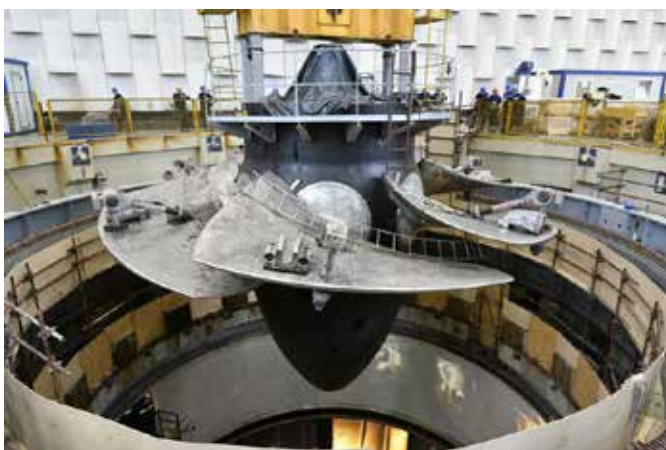
Слика 2 – Сиушћање новог радног кола турбине у јаму хидроагрегата (извор АД ЕПС)
