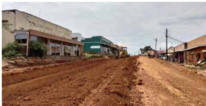
Израда доње носеће слоја (subbase-a), скарификација њосијеће материјала, Митана траске саобраћајнице
