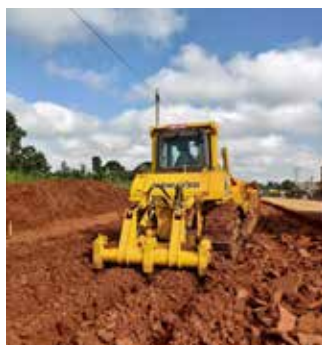
Израда доње носеће слоја (subbase-a), скарификација њосијеће материјала, Митана траске саобраћајнице
