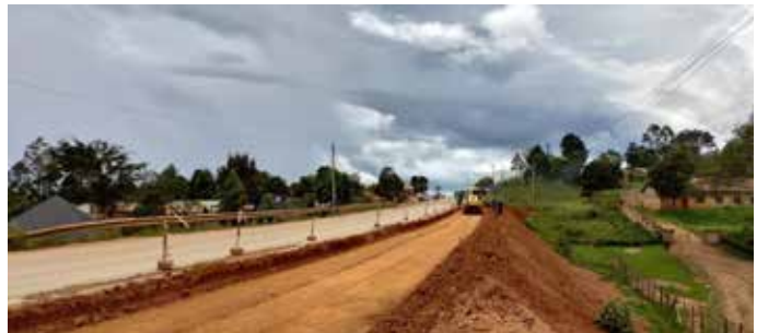
Груби земљани радови, проширивање постојеће пута
