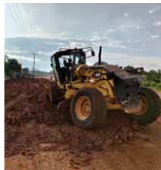
Израда доње носеће слоја (subbase-a), скарификација њосијеће материјала, Митана траске саобраћајнице
