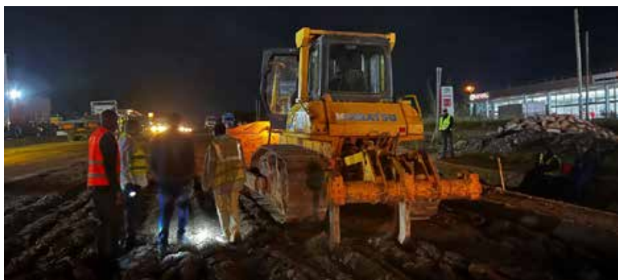
Скарификација њосијеће коловозне констирукције
